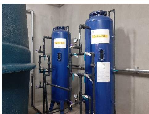
ระบบนำน้ำที่ผ่านการบำบัดมาใช้ประโยชน์
